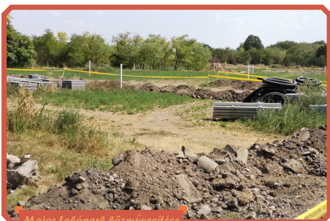
Major Lakópark közművesítése
