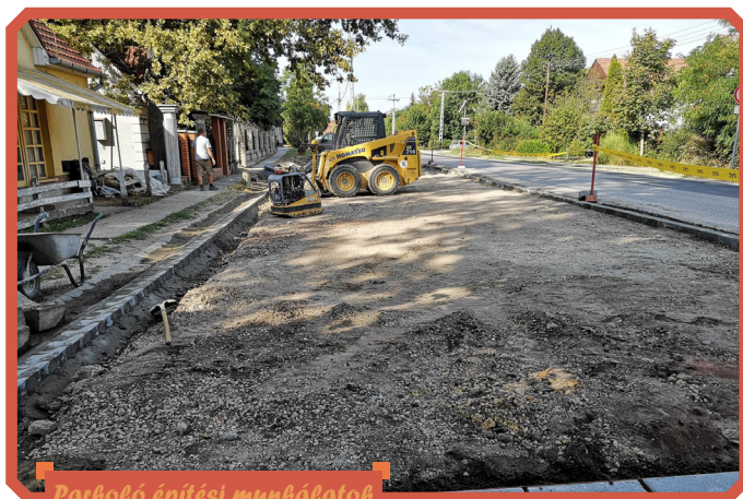
Parkoló építési munkálatok
